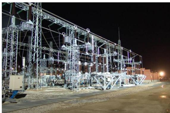
Рис. 6. Подстанция 750/500 кВ Белый Раст (открытое распределительное устройство – ОРУ 110 кВ)
